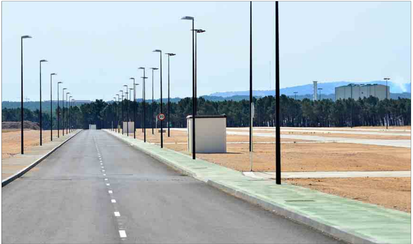
Estado del suelo industrial de la CMA, cuyas obras ya han concluido. / ÁLVARO MARTÍNEZ
